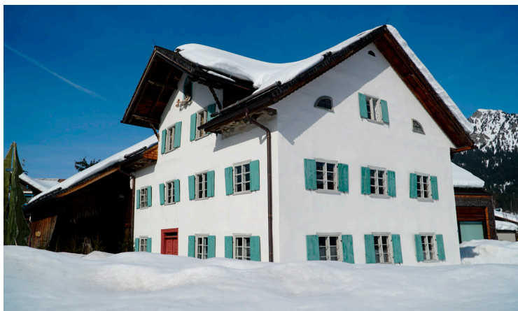
Das Gebäude wird dank einer umfassenden Sanierung heute auf vielfältige Weise genutzt.
